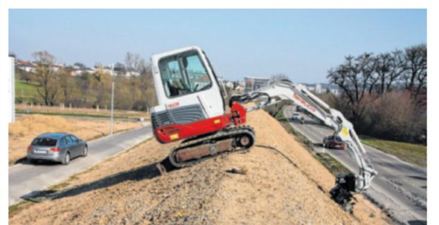
Am Lärmschutzwall des Solparks in Hesselental wird fleißig gearbeitet. Zu sehen sind die Vorarbeiten „Fräsen Lärmschutzwall“ für die anstehende Begrünung des Walls. Dabei ist eine Fräse an einem Bagger im Einsatz. *Foto: privat*
